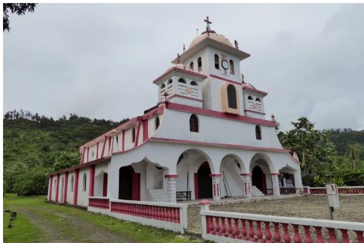
Eglise de Fiuva, Futuna
