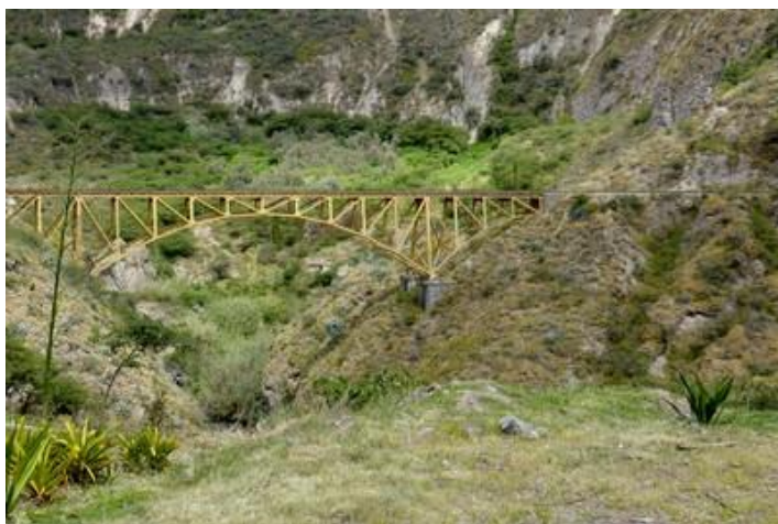
Pont ferroviaire sur le Rio Ambo, vers Hoja Blanca
