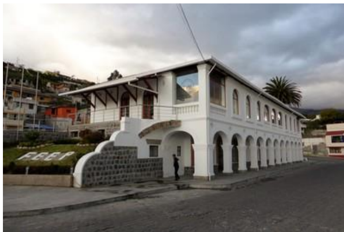
Gare rénovée, Otavalo
