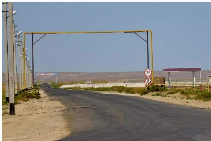
Conduites de gaz au Mangistau
