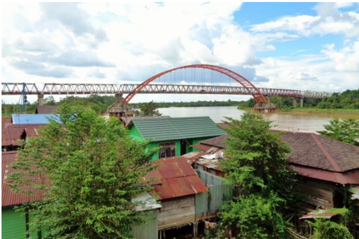
Pont sur la rivière Kahayan, Palangkaraya (Kalimantan)
