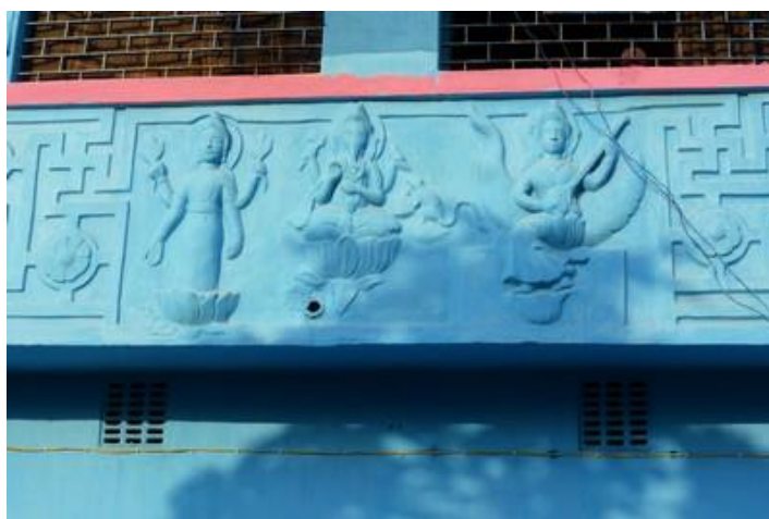
En façade d'une maison, Madhuban
