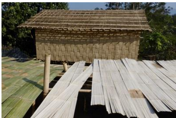
Maison en construction, Damdai
