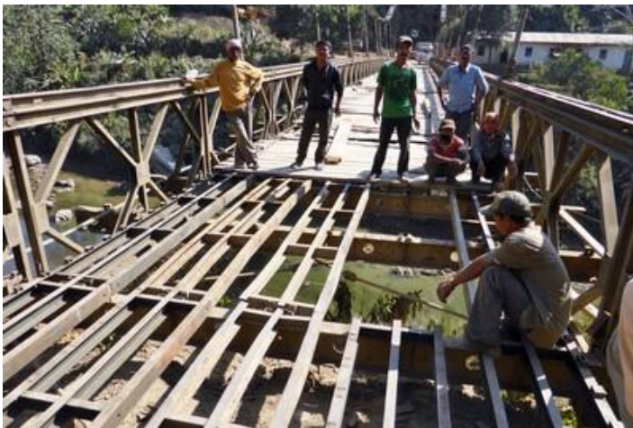
Réparation du pont, route d'Imphal
