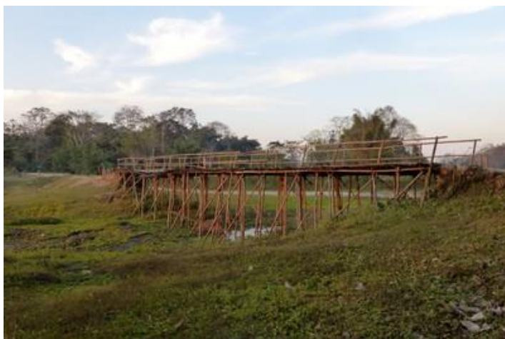
Un pont piétonnier, Garamur, île de Majuli
