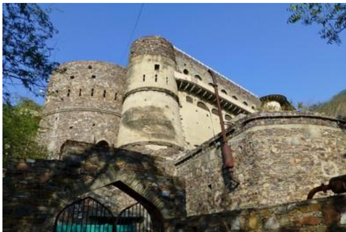
Fort de Neemrana
