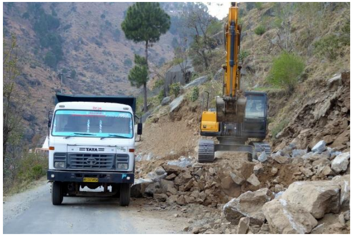
Eboullis, route de Bharmour
