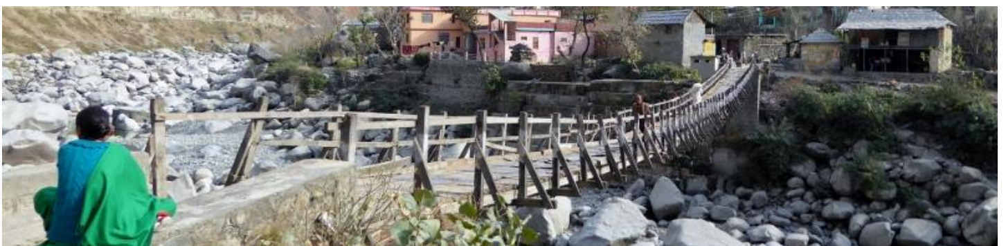
Pont suspendu, route de Chamba
