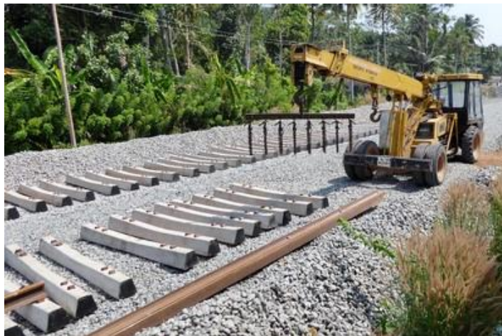
Construction d'une nouvelle voie ferrée vers Ambalapuzha
