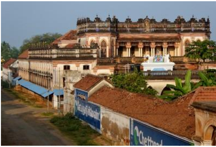
Vue depuis ma chambre, Chettinadu Mansion, Kanadukathan
