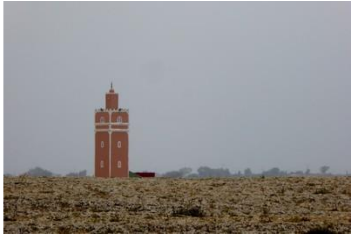
Minaret vers Sidi Bouchta
