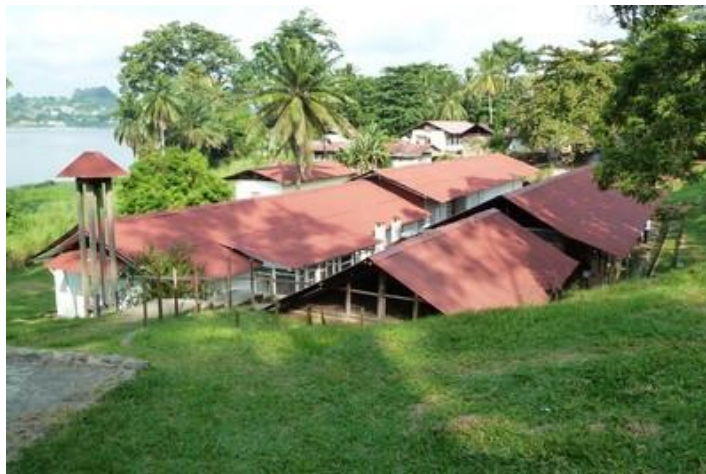
Ancien hôpital d'Albert Schweitzer, Lambaréné
