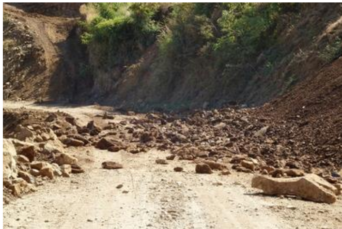
Eboulement sur la route, vers Adi Ar Kay
