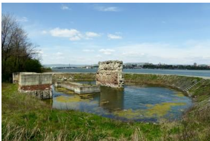
Restes du pont de Trajan (II S), vers Kladovo
