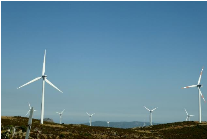
Eoliennes, route d'Ulassai
